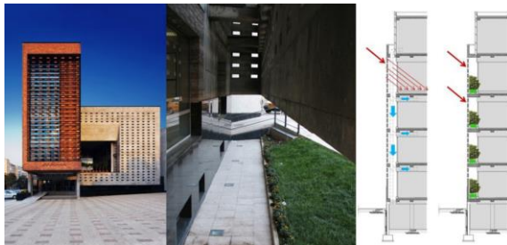
شکل (۴): استفاده از نمای دوپوسته در بنای سازمان نظام مهندسی قزوین
