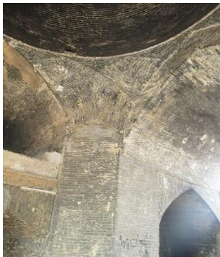
شکل ۲۸- کاربندی آجری داخل هشتی
