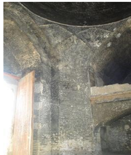
شکل ۲۷- کاربندی آجری داخل هشتی
